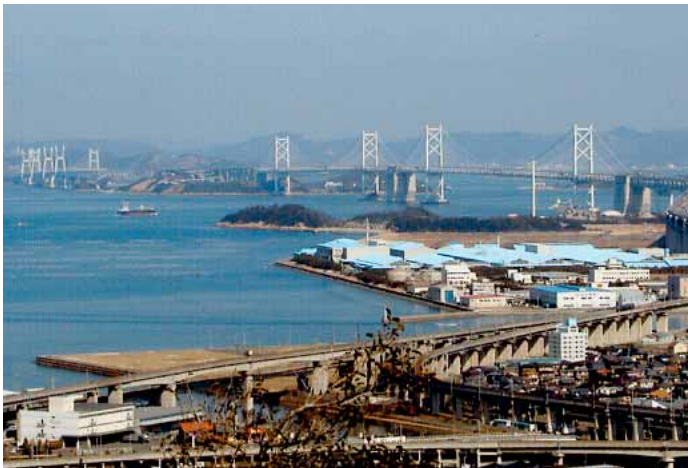
青の山から見た瀬戸大橋
